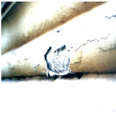
Fig. 5 - Palácio brasileiro do séc. XIX e edifício em Lisboa: repintura com membrana com degradação
