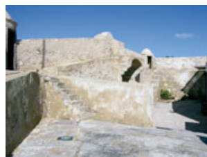
Fig. 3 - Rebocos de substituição recente em Forte perto de Lisboa: perda de coesão
