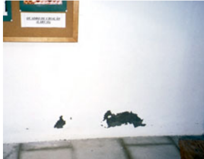
Fig. 9 - Humidade em paramentos interiores de edifícios antigos, devidas a capilaridade ascendente
