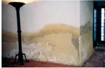
Fig. 8 - Humidade em paramentos interiores de edifícios antigos, devidas a capilaridade ascendente
