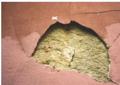
Fig. 6 - Camadas de acabamento de substituição de cimento: destacamento e degradação da base
