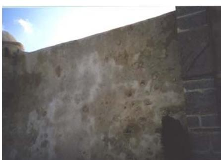
Fig. 4 – Revestimentos de substituição num Forte, com eflorescências e erosão
