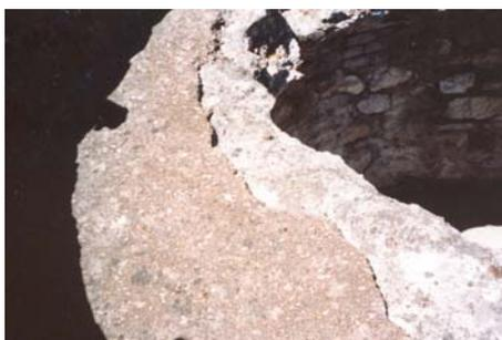
Fig. 1 – Revestimento antigo em várias camadas
