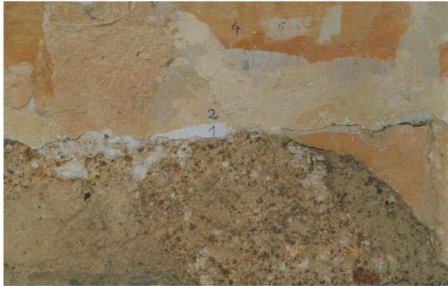
↑ Fig.1 - Identificación de las capas de pintura
