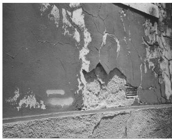
Fig.2 Destacamento do reboco, surgimento de bolhas e lacunas.
