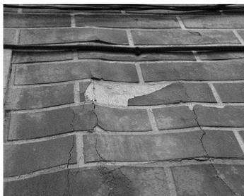
Fig.1 Revestimento com abaulamento do suporte, fissuras e destacamento da pintura
