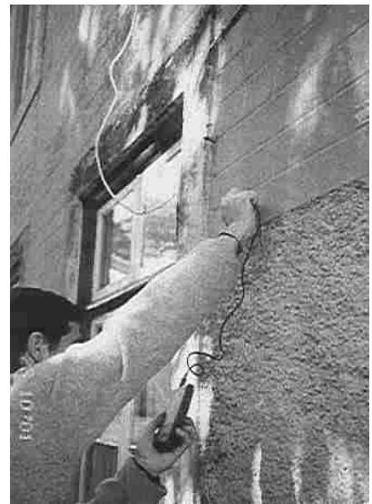
Fig.3 Ensayo con humidímetro en el edificio de Sintra
