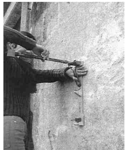
Fig.6 Ensayo de penetración controlada en el edificio de Lisboa
